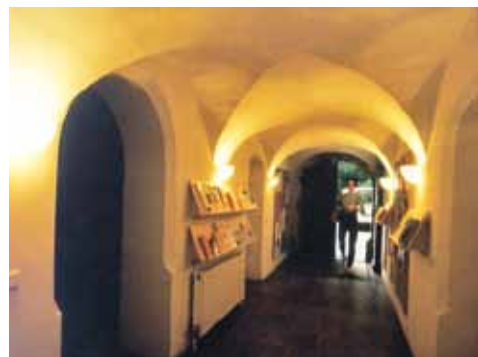
Kreuzgratgewölbe im Eingangsbereich
